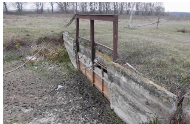
Ліквідація ГТС з подальшим облаштуванням мостового переїзду
